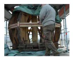
Der Kaiserstiel ist so durchfault und innen hohl, dass er komplett ersetzt werden muss. Mit einer Kantenlänge von 30 Zentimetern, einer Höhe von rund fünfeinhalb Metern und einem Gewicht von etwa 350 Kilo, trägt der Kaiserstil das Turmkreuz auf dem der Hahn sitzt.
