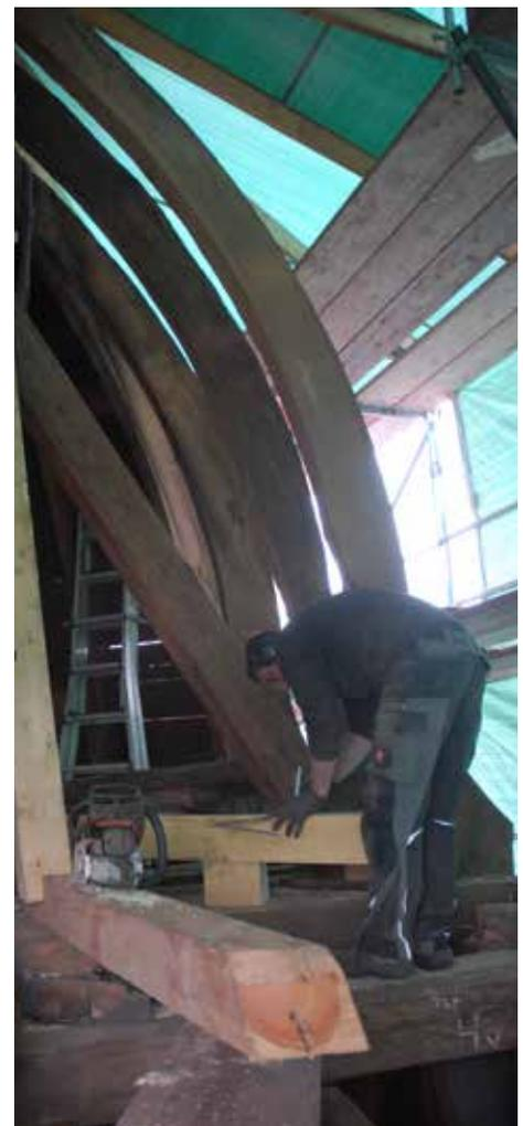
*Ein Zimmermann bei der Arbeit in der Ebene über dem Glockenstuhl. Die gebogenen Balken sind zum Teil ausgebaut, damit die darunter liegenden Balken erneuert werden können.*
