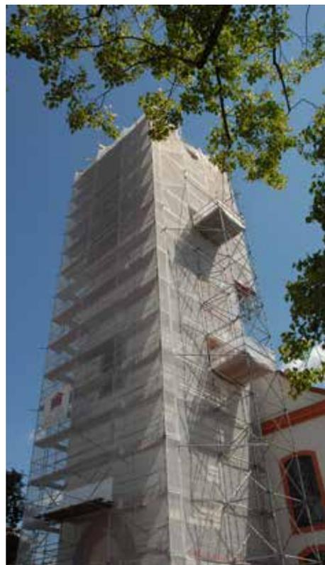
(md) Eigentlich sollten die Arbeiten längst abgeschlossen sein. Unvorhersehbare Schäden zwingen die Zimmerleute jedoch immer wieder, Balken teilweise oder ganz zu ersetzen. Mit einer Fertigstellung vor dem Frühjahr 2016 ist nicht mehr zu rechnen.
