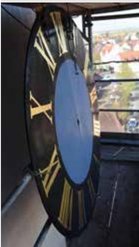
Bild links: Eines der vier Ziffernblätter aus Kupfer, die überarbeitet werden.
