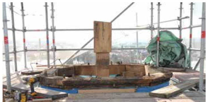
Bild rechts: Die Kirchturmspitze ohne obere Kugel und mit abgesägtem Kaiserstiel.
