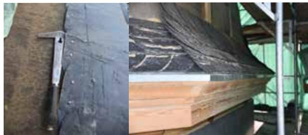
Bilder oben: Dachdeckerarbeiten und ein Gesims, das aufgrund von Vorgaben der Denkmalpflege in einem kräftigeren Rot als bisher erscheinen wird. Die Fassade bekommt einen hellen, rötlich-gebrochenen Weißanstrich.
